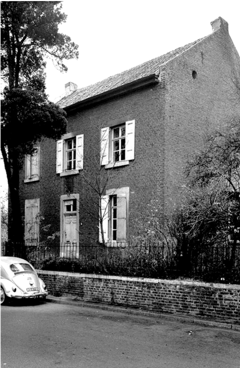
Woonhuis Beckers aan de Hoofdstraat
